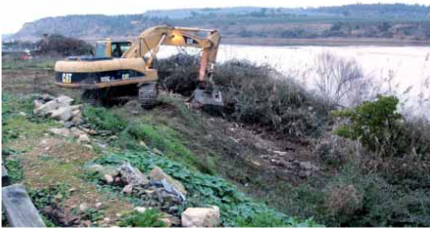
Vista general de l'obra.
