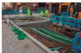
Medir zonas con gran cantidad de instalaciones
