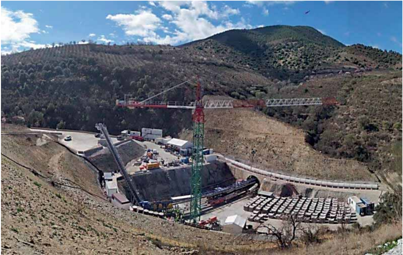
Vista general de las instalaciones de Paracuellos. Inicio del segundo tramo.
