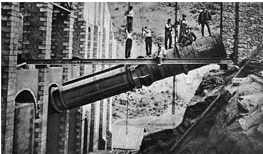
Instal·lació d'un secador de carbó.
