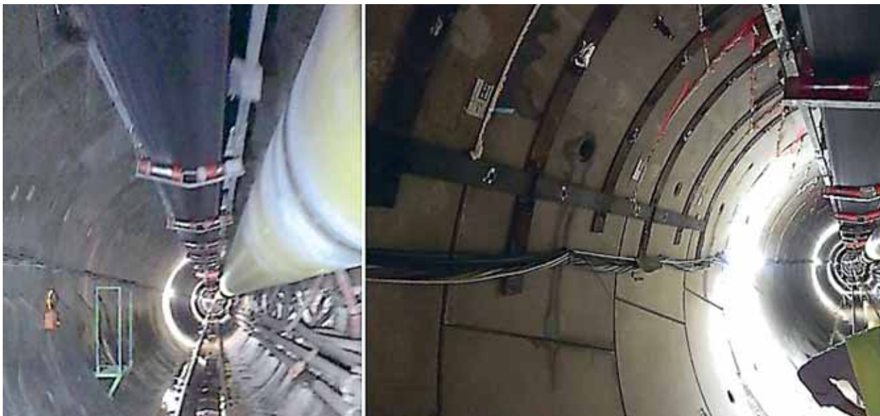
Interior del túnel de Mularroya con la cinta de desescombro en clave, tubo de ventilación y burladeros para descenso e inspecciones, y refuerzos provisionales.
